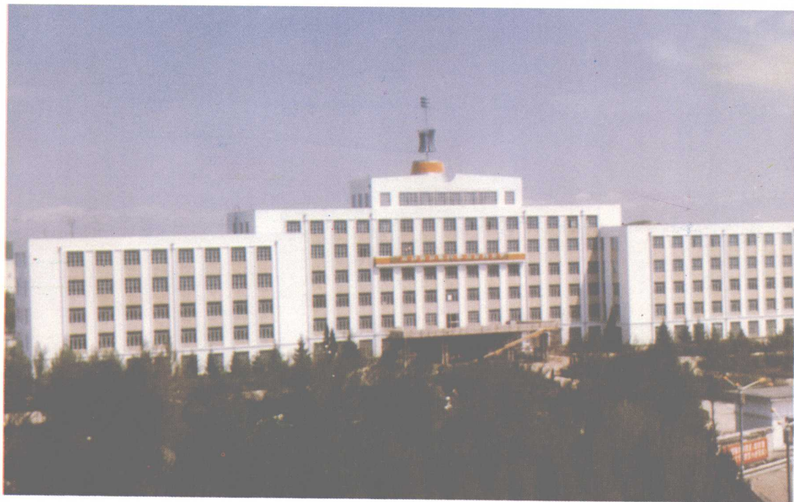
七台河矿务局办公楼
