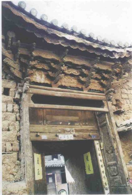
7.木雕斗拱一滴水大门（明代，大理挖色） 门头斗拱6排“龙”头，共36条，少量“凤”头，底部雕有云彩，建造精美。
