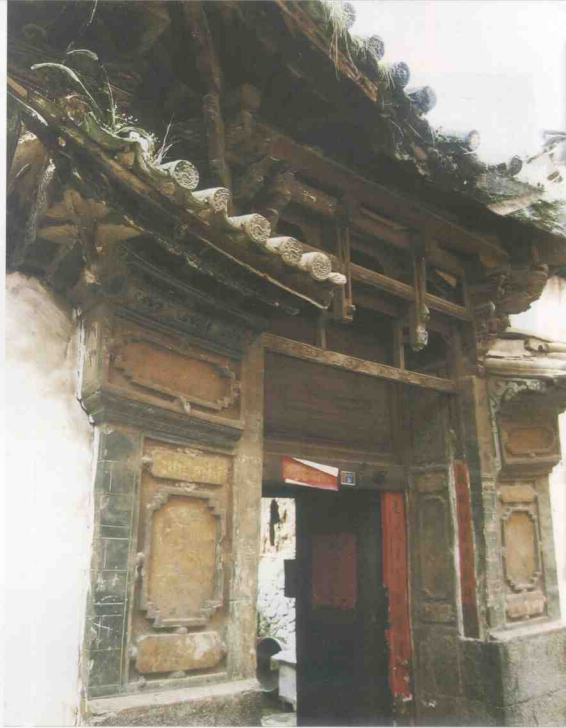
11. 吊柱三滴水大门（明代，大理双廊） 门的顶部用的全是上等木材，结构复杂，今为少见。
