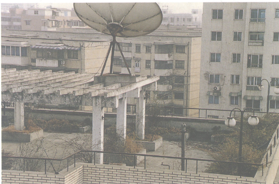
早期的屋顶花园棚架，沿用了粗重的水泥预制块，影响承重，又乏美感
