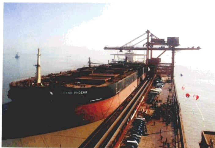
北仑港 20 万吨级矿石中转泊位
