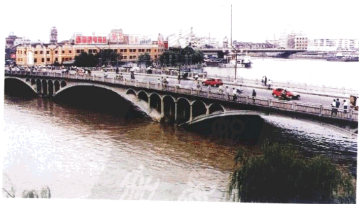
1970 年改造后的新江桥
