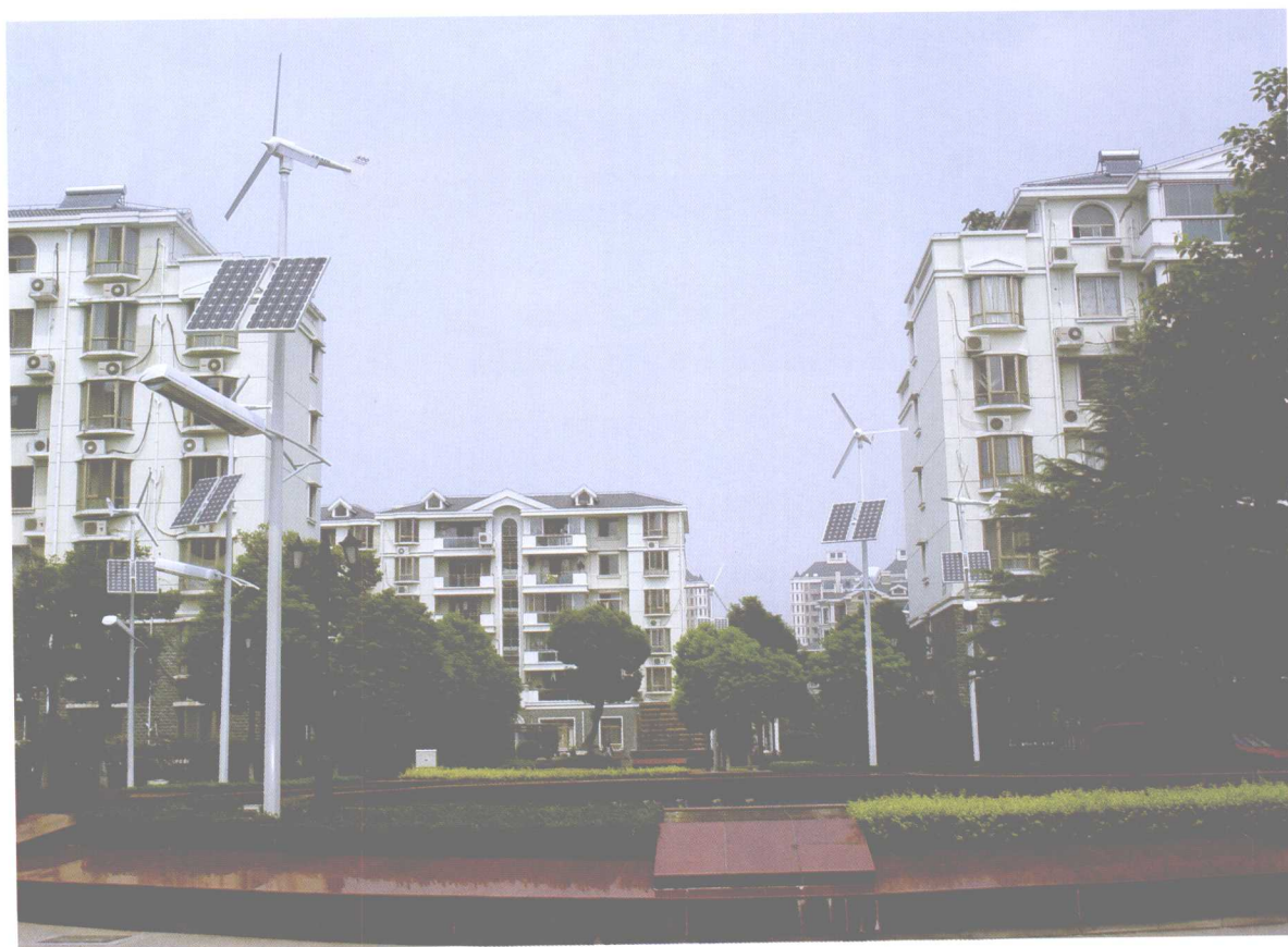
闵行区锦峰苑住宅小区节能环保示范工程
