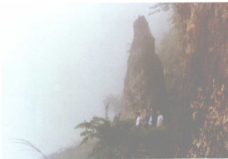
1985年7月3日，考察新滩滑坡，这是在云雾飘渺中的滑坡体后缘，岩体剥离，形成一座石笋，开裂仍有加大趋势。
