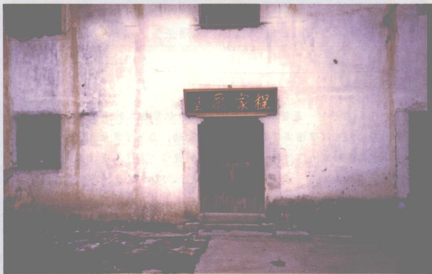
临安县乐平乡外伍村程家厅堂旧址
