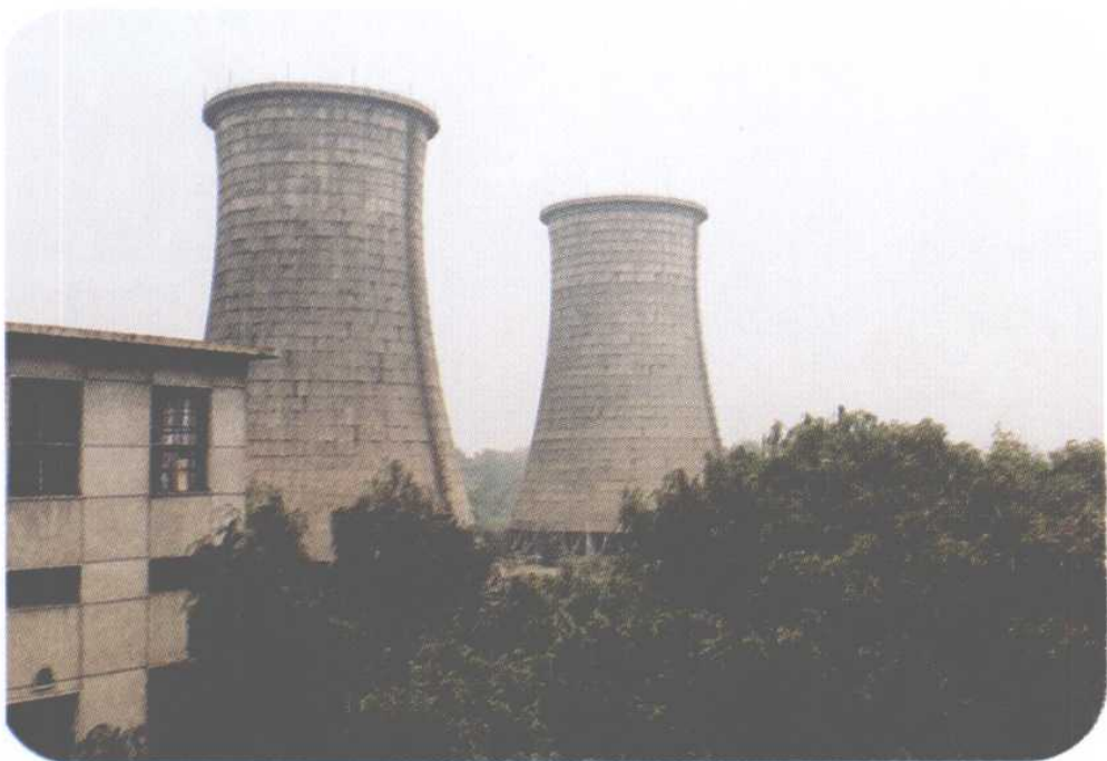
全国最大的煤矸石发电厂——钱营发电厂
