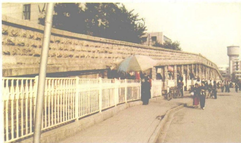
石家庄大石桥
