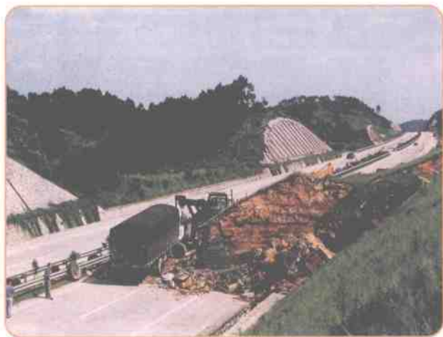
滑坡破坏交通(南柳高速公路, 2004年)
