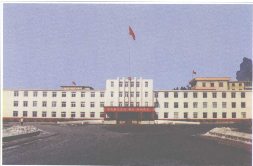
新宾满族自治县县政府办公楼
