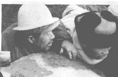
市特等劳动模范王世才(左一)带领市政工程公司二工段的施工人员,创下日铺设钢筋水泥管 73 根纪录
