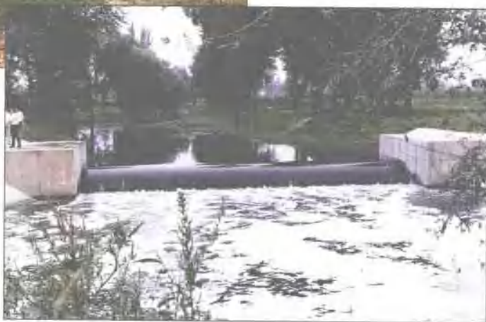
大兴第一座橡胶坝
