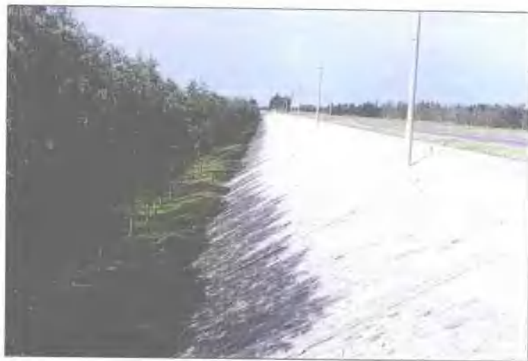
永定河西麻各庄险工 段浆砌石护坡
