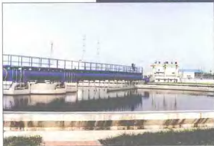
黄村污水处理厂一角
