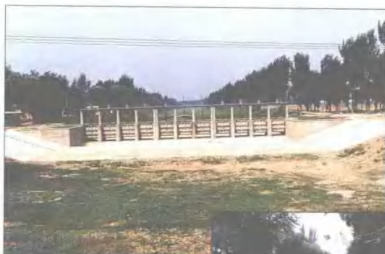
天堂河南各庄节制闸
