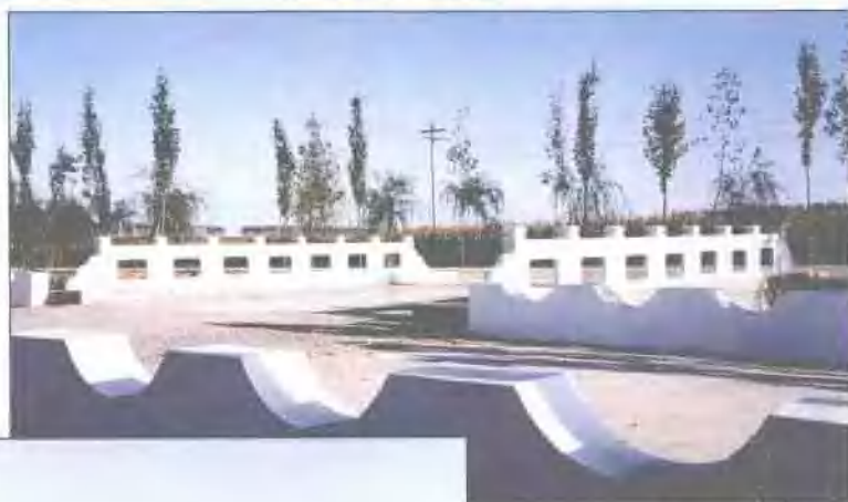
田间排涝配套工程
