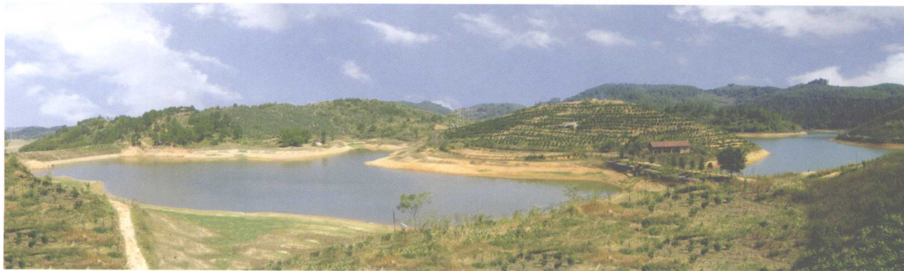
冲北水库，位于沙塘镇上垌村，1953年3月建成，总库容126万立方米，设计灌溉153公顷。（李厚全 摄）
