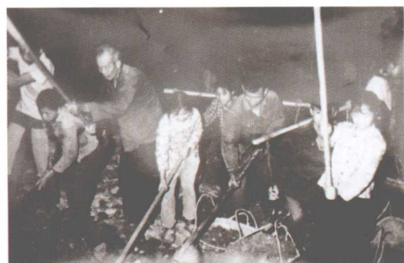
1974 年，郊区柳东大队大搞农田基本建设和兴修水利，组织社员挑灯夜战修梯田。（覃岭 摄）
