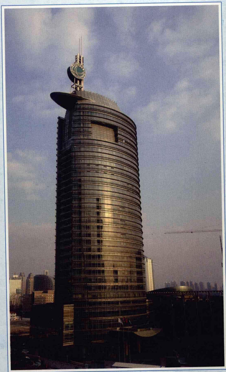
上海市电力公司大楼
