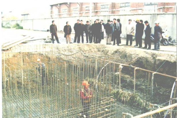
2005年,市政协视察正在建设中的污水处理工程
