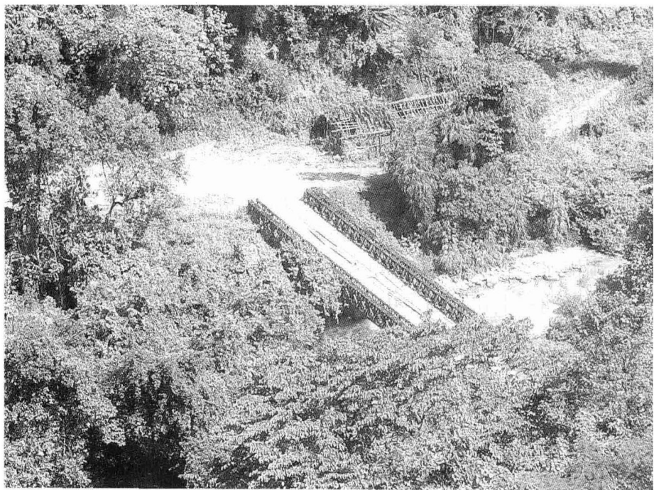
史迪威公路上的钢架桥
