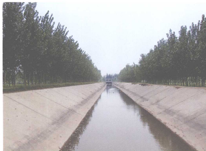
大型灌区续建配套与节水改造工程——第三濮清南干渠衬砌
