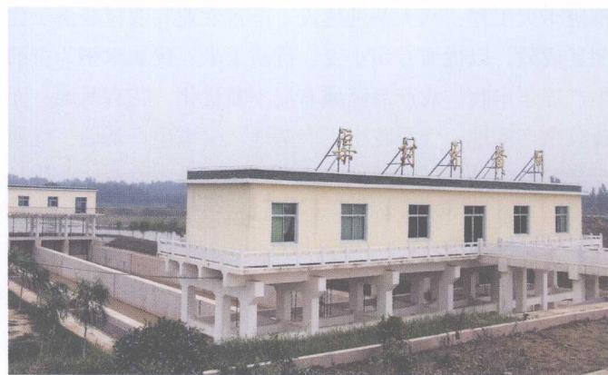
改建后的渠村引黄闸
