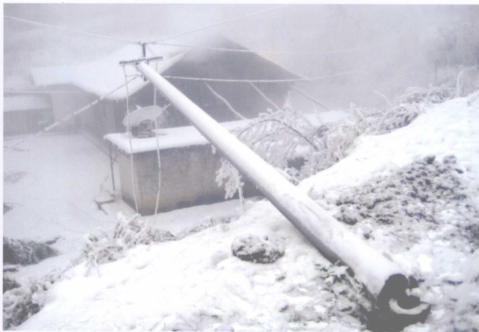
雪灾导致全省农村电网受损严重。
