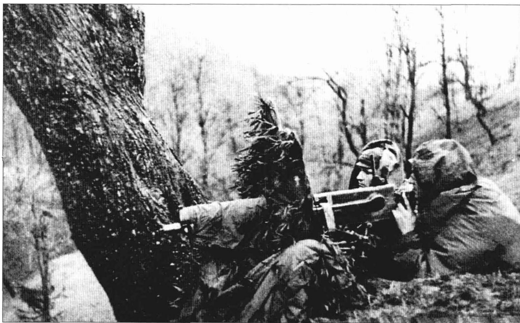
■ 1940年秋季参加莫斯科军区演习的红军7.62毫米马克沁机枪射手，该机枪射速达每分钟520至600发，采用布制弹带供弹，但是沉重而缺乏机动性。
