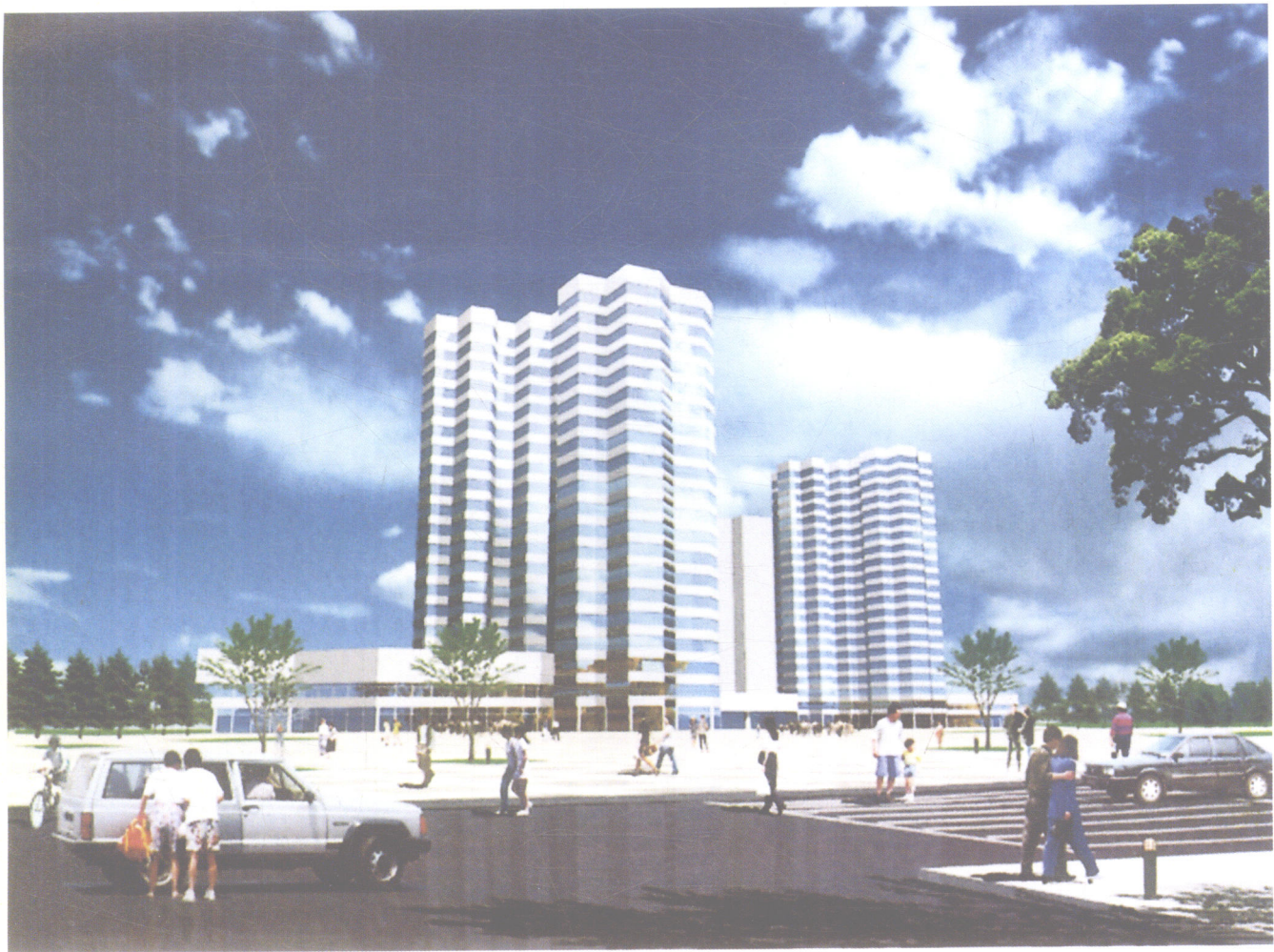
太原市政府综合办公大楼
