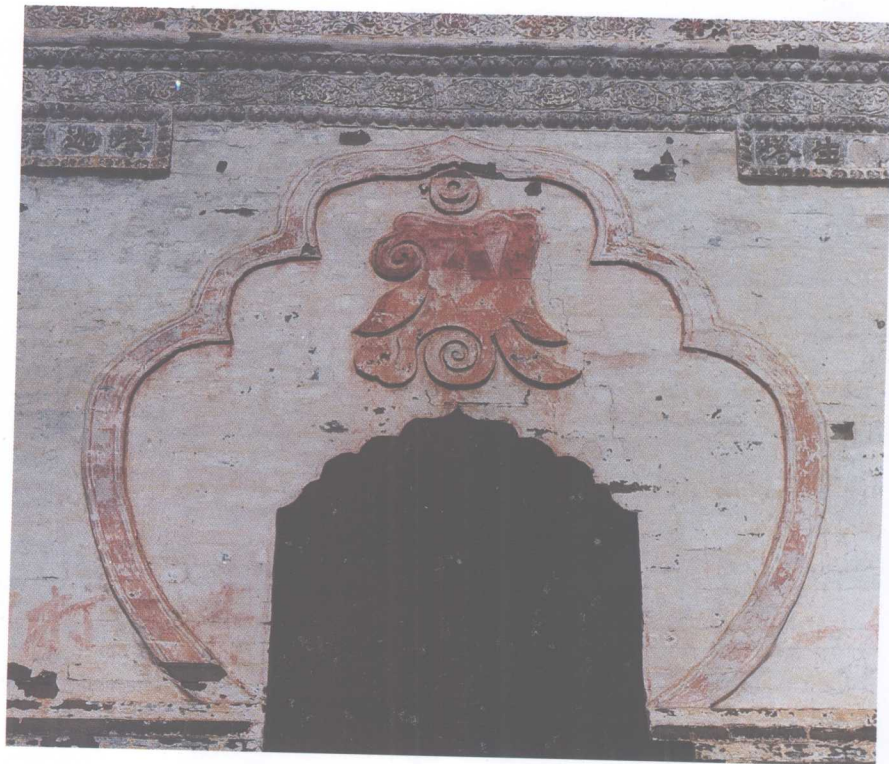
右图：四祖寺当年规模宏大，殿阁众多，后多毁于战火，现存建筑上美丽的雕饰，还可令人想见当年盛况。这是四祖寺的唐代毗卢塔局部，体态稳重，气势轩昂。毗卢塔为道信灵塔，砖石仿木构，高约十五米，重檐亭式。毗卢塔在台基略成正方形，基上须弥座高大，雕纹饰刻流畅。塔身东、西、南面设莲弧门，四面墙头砌铭有诸佛法号的雕字砖，顶作四注式，中覆铁镡。
