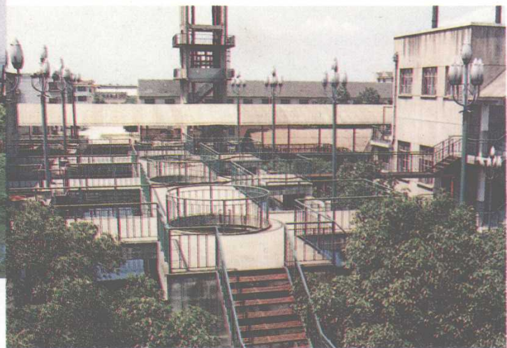
污水处理装置
