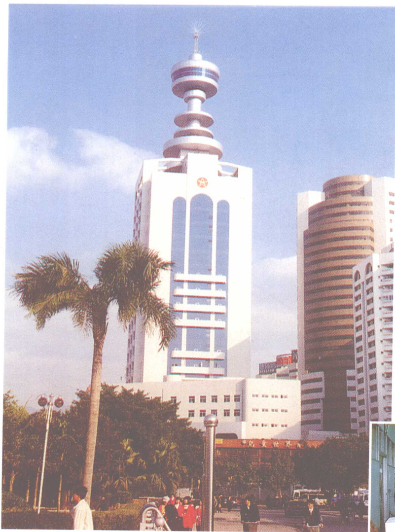
福州长途电信枢纽大楼
