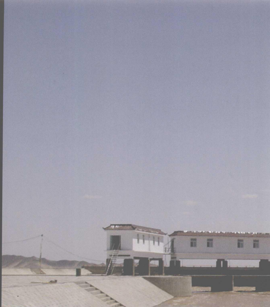
黑河一渠道衬砌输水工程
