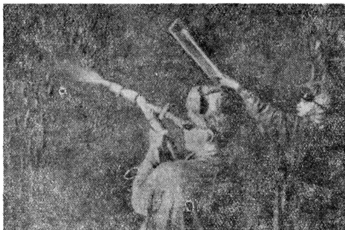
圖一 用機械化方法噴刷牆壁
