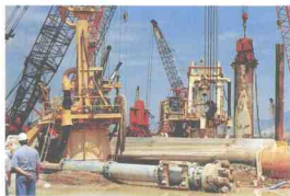
现场上的打桩钻井设备
