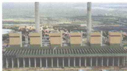
南非 Matimba 直接空气冷却器发电厂，装机容量 6 x 665 MWe
