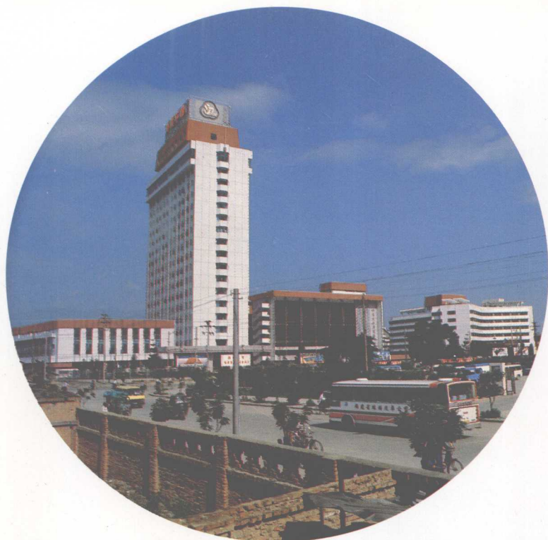
⇐福建省外贸中心大楼（省轻工业品进出口公司设在4层）
