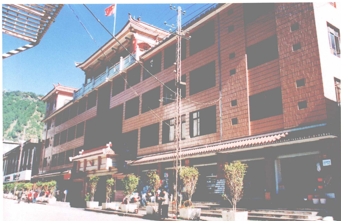
县四大机关办公大楼
