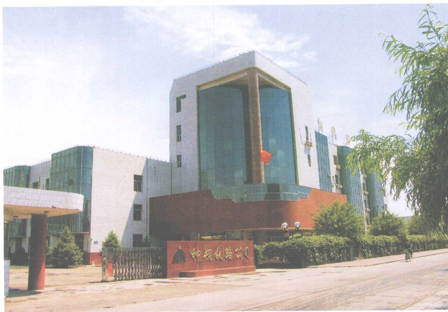
◆ 神朔铁路公司办公楼
