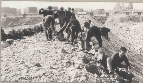
人拉肩扛，没有道路自己修，没有房子自己盖。图为镇海炼化施工现场。
