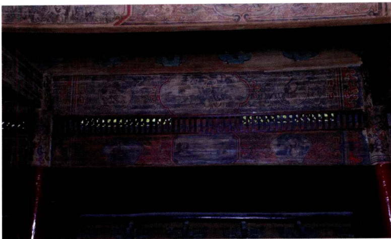
▲西梢间西侧中间两根重檐柱间额枋及承椽枋彩画
