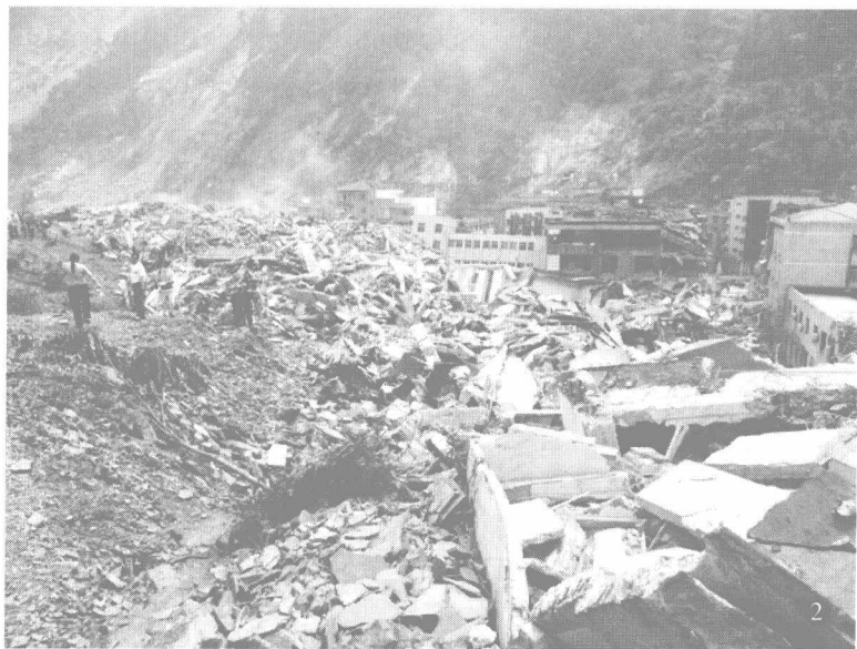
② 震后的北川法院已成废墟
