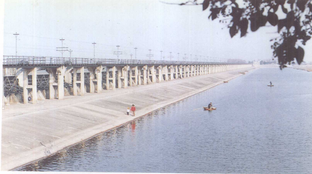
▶ 荆江分洪区太平 口北闸进洪工程
