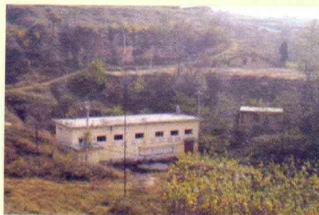
胡家洼水库提水站机房
