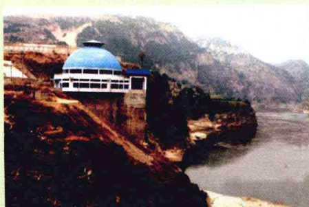
黄河槐机提水工程一级泵站
