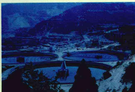
槐机提水工程沉沙池
