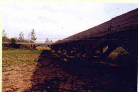
胡家洼水库提水站渡槽
