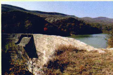
高崖薄壳拱型坝水库
