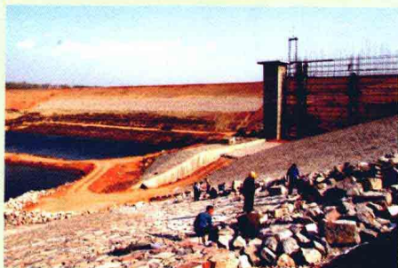
西段村水库迎水坡
