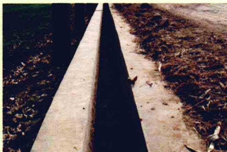
仁村灌区渠道
