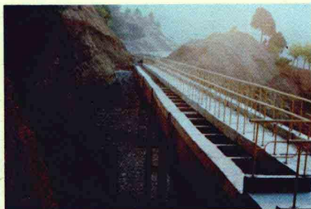
槐机工程五号渡槽
