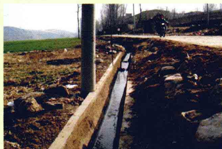
仁村乡大水沟U型渠道
