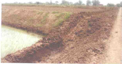
图3 平整地块,整治坑塘
