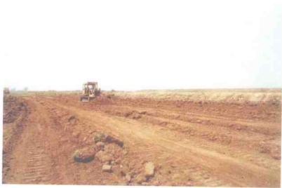
图4 建设中的项目区
