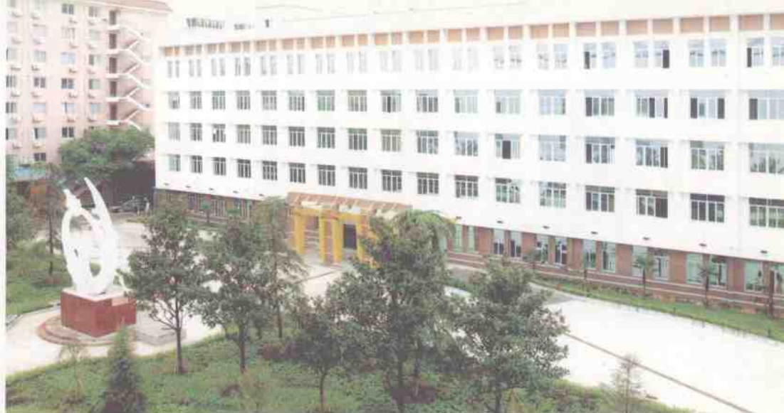
► 修葺一新的湖南省体育局办公楼。
