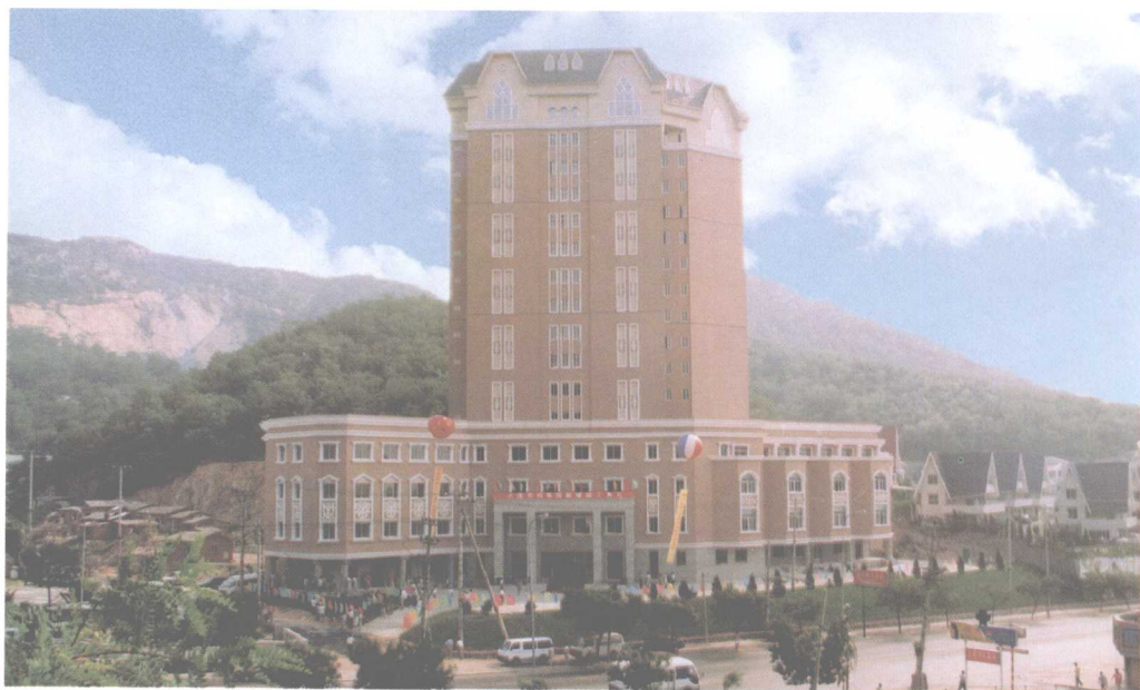
座落于中山 区中南路 49 号 的大连市档案 馆新大楼外景
