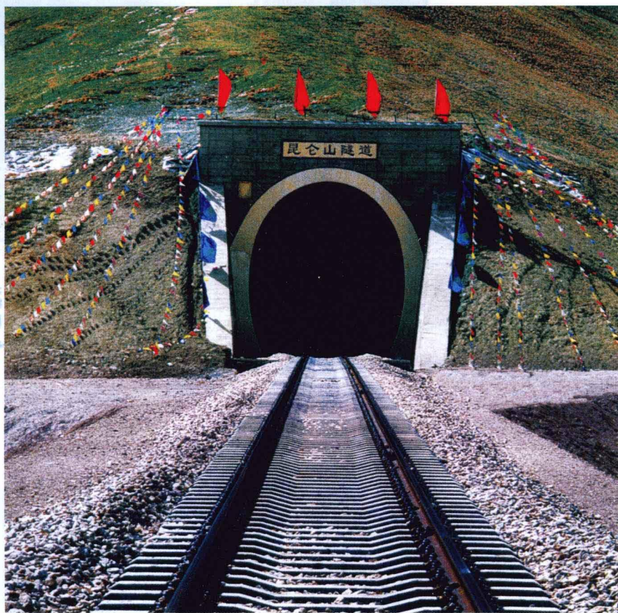
青藏铁路最长的隧道——昆仑山隧道
