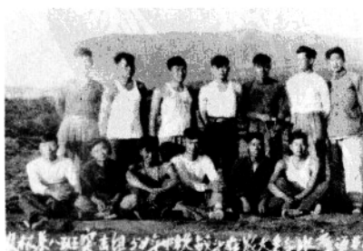
16. 农管系学生在修建青年水库大坝工地上劳动间隙时留影
