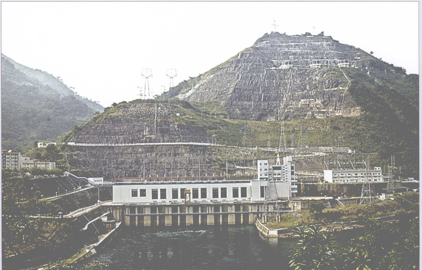
图1.2 完成治理后的调压井边坡及厂房边坡正面
