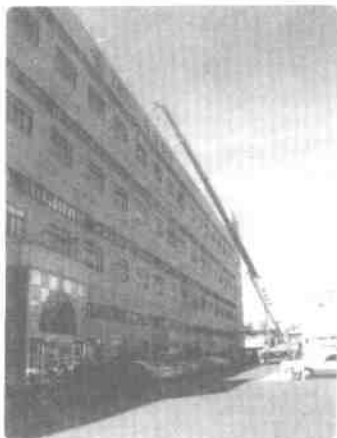
▲ 采购大型变压器应指定在楼顶交货。倘若在一楼交货，则还要将大型变压器吊上楼顶，势必要多出一笔花费。
