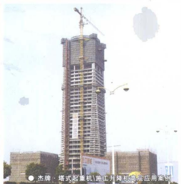
● 杰牌·塔式起重机/施工升降机高层应用案例
