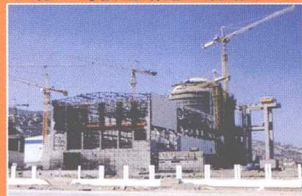
福建LNG天然氣接收工程施工程場↓
