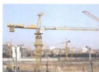
和记黄埔 黄沙地铁商住楼 9台QTZ系列塔机
