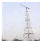
500KV台香输变电 215.5米钢管塔 2台STT293 安装高度230米 中国第一高钢管塔
