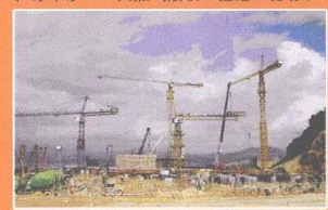
廣東嶺澳核電站二期工程施工程場↓
