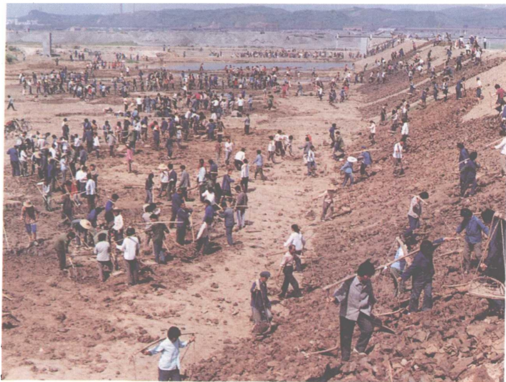
水利施工工地
