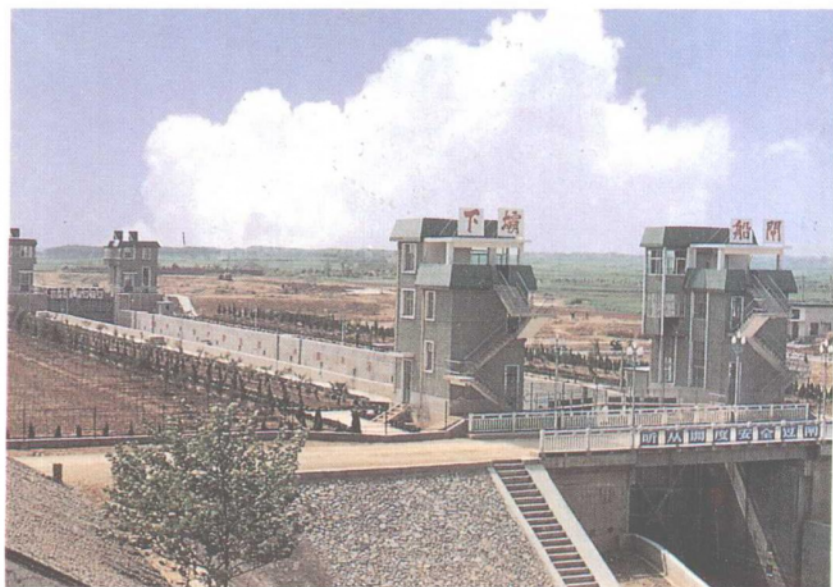
胥河下坝船闸
