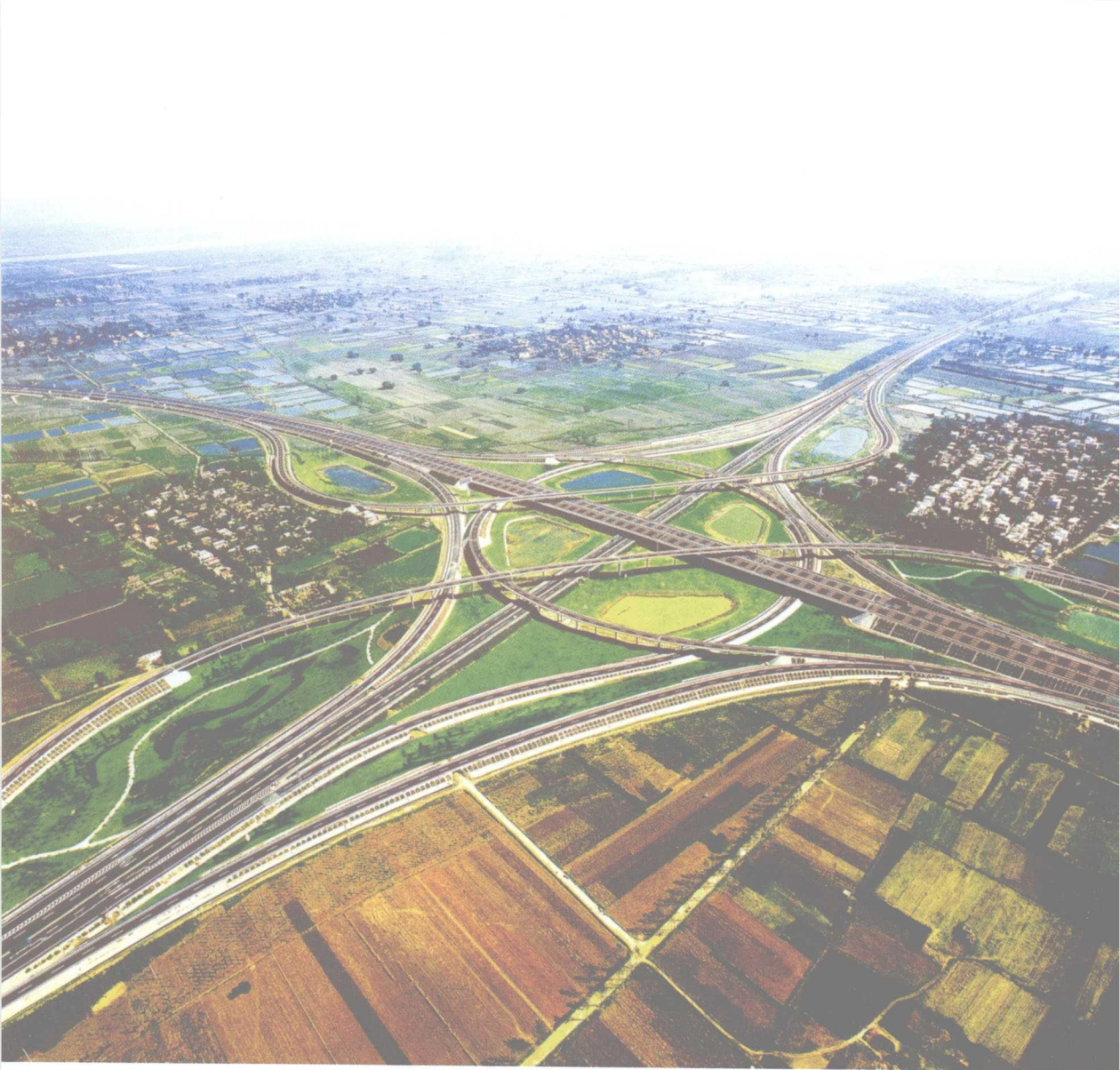
高速公路立交桥
