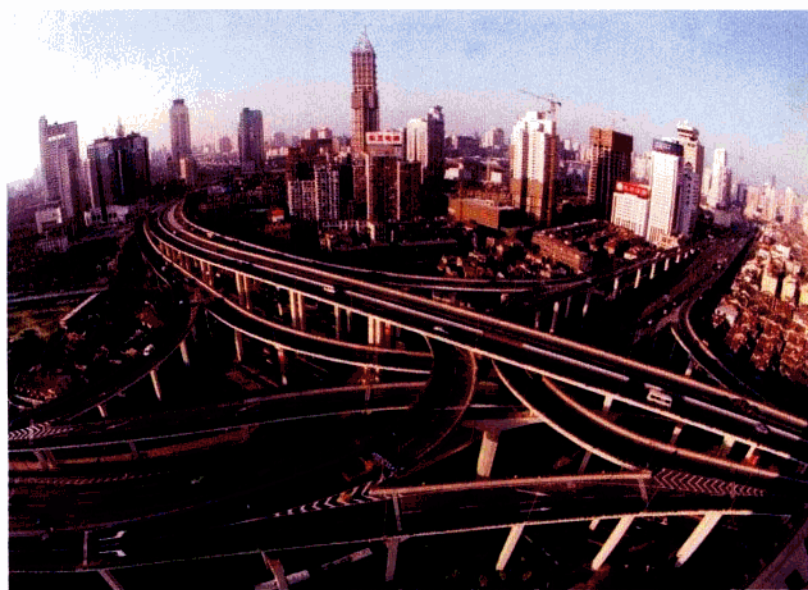
▲ 四通八达的高架道路 / 杨焕敏 摄影
