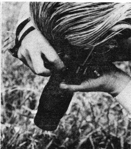
❷——左圖表示側攝時的標準手托相機方法。100%微距鏡頭向前伸長的相當長，這時要記得常用比 $1/120\sim1/250$ 秒還要快的快門速度。右圖垂直拍攝時的手托相機方法。因為這時的相機要比側攝時難以穩住，應須注意。不妨使用未裝軟片的相機練習按動快門，把托機法練熟。
