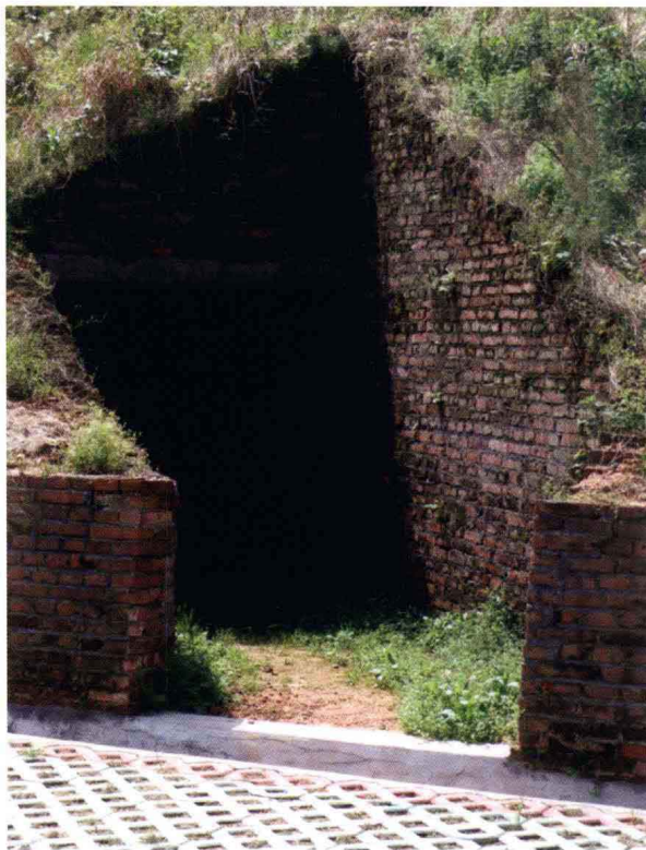
长沙窑遗址中的挖泥洞。
