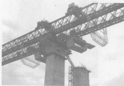
图 1-11 采用桁架式架桥机悬拼施工的 苏通大桥深水区段引桥
