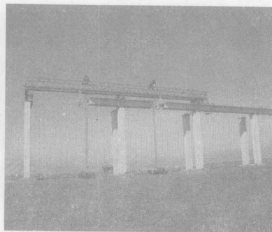
图 1-12 正在进行节段吊装施工的 苏通大桥深水区段引桥
