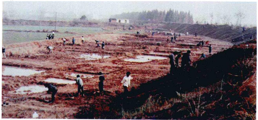
► 群众积极投入富春江堤防建设
