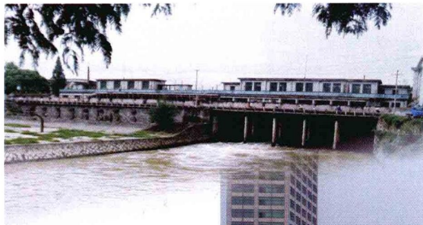
▲1962年建成的苕浦闸 (2004年拆除)
