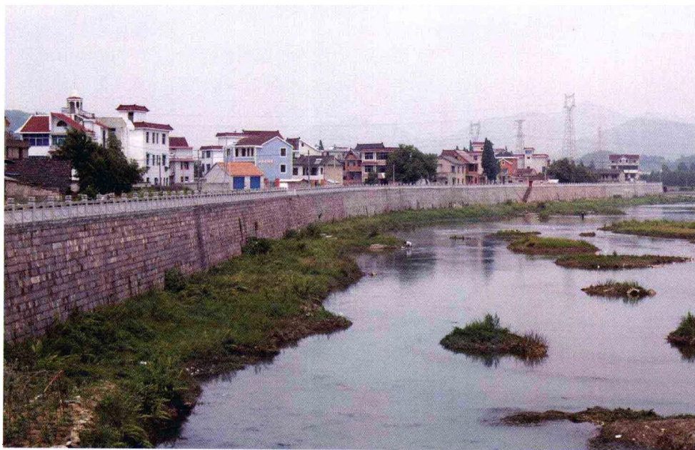
▲ 新登城市防洪工程
