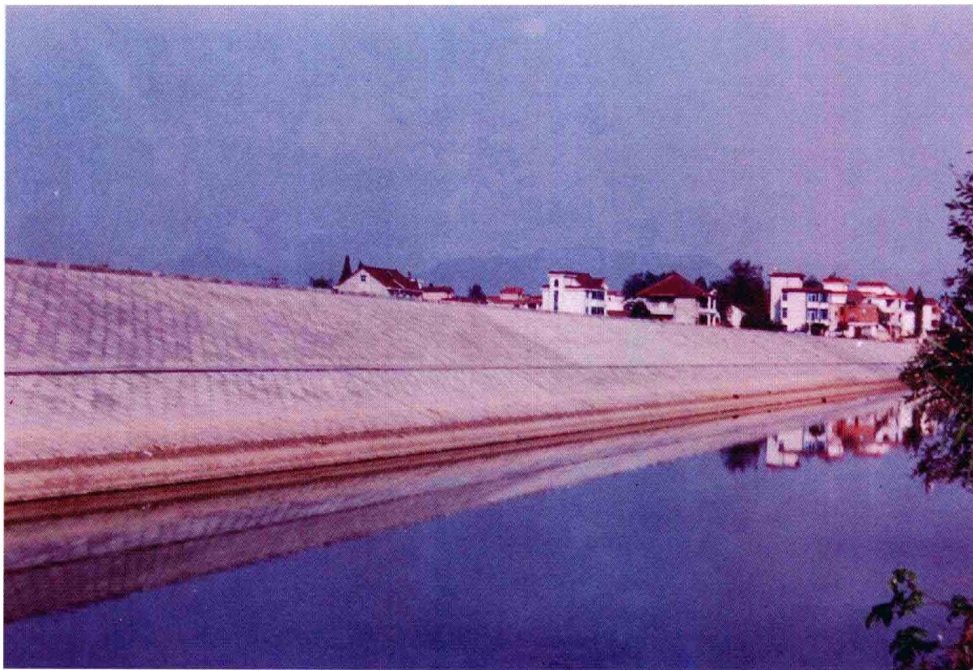
▲ 富阳城市防洪工程——南渠堤
